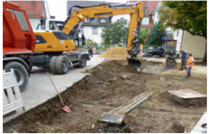
Die komplette Straße wird um 70-80 cm ausgekoffert und der Abraum abtransportiert
