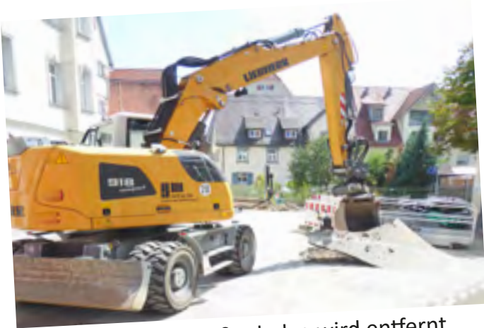
Der Asphalt-Straßenbelag wird entfernt
